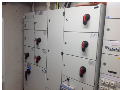
Sähköpääkeskuksen laitteisto
