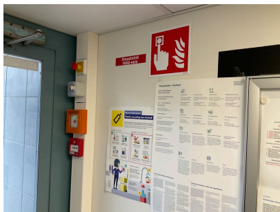
Iv-hätäseis, savunpoiston laukaisu ja palovaroitinpainike
