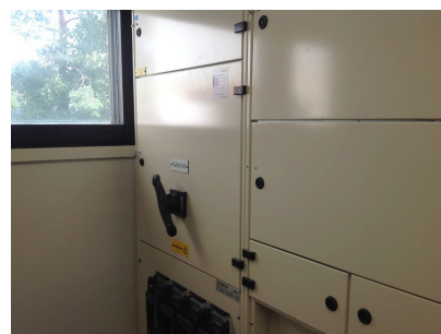
Sähköpääkytkin
