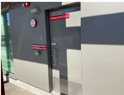
Kulku sprinklerikeskukselle ja palokunnan putkilukko
