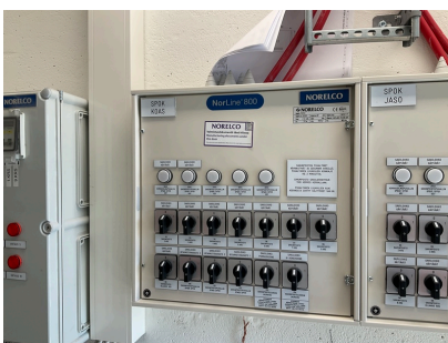
Savunpoistokeskus sprinkleri-huoneessa
