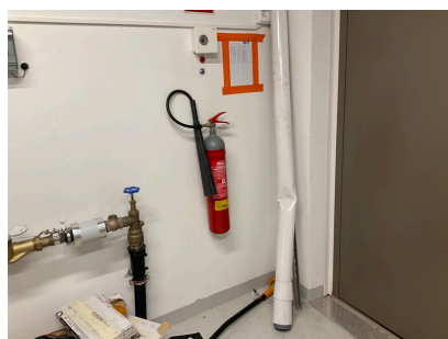
5kg CO2-sammutin teknisissä tiloissa sekä palokunnan putkilukko
