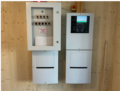
A- ja B-talon savunpoistokeskus, palovaroitinkeskus sekä ilmanvaihdon hätäseispainike
