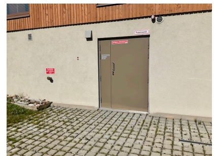
Teknisten tilojen sisäänkäynti ja palokunnan putkilukko sekä syöttöliitin
