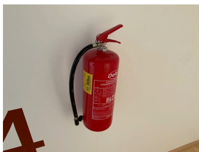
Kerroksien 6kg ABC-jauhe-sammuttimet
