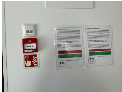
Palohälytyksen kuittaus ja paloilmoinpainike
