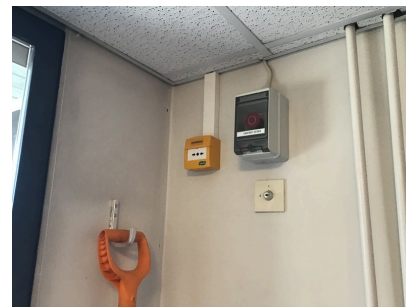
Savunpoiston etälaukaisu ja ilmanvaihdon hätä-seis-painike
