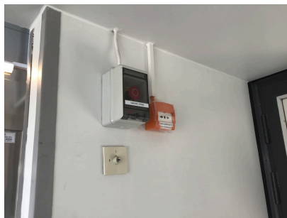
Savunpoisto etälaukaisu ja ilmanvaihdon hätä-seis-painike
