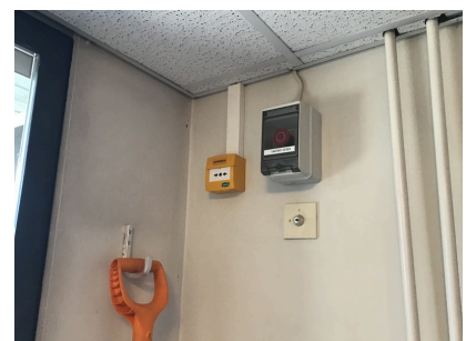
Savunpoiston etälaukaisu ja ilmanvaihdon hätä-seis-painike
