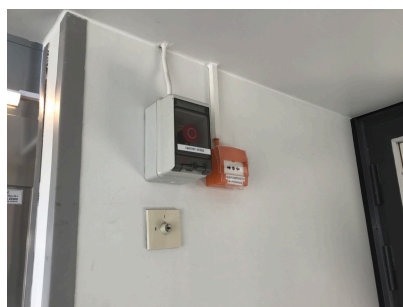
Savunpoisto etälaukaisu ja ilmanvaihdon hätä-seis-painike
