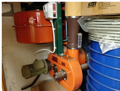
Väestönsuojan ilmanvaihtolaitteisto
